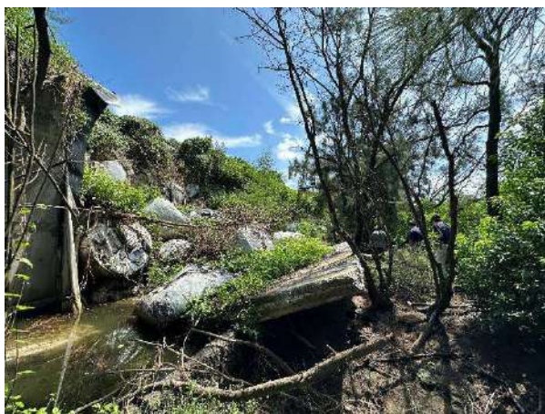
圖 3-136、臺南市安南區城西灰渣場擋土牆開裂倒塌
