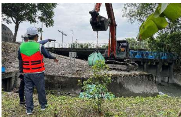
圖 3-84、花蓮豐田沉砂池大型機具吊掛太空包
