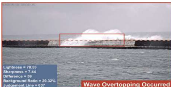
圖 3-35、港區防波堤越波影像判釋
