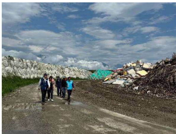
圖 3-137、勘察掩埋場災後垃圾暫置情形
