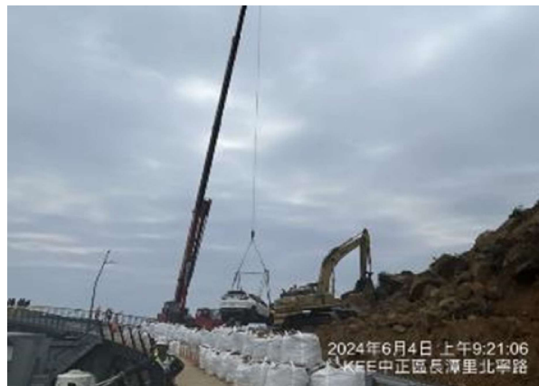
圖 1-24、現場吊離受困車輛
