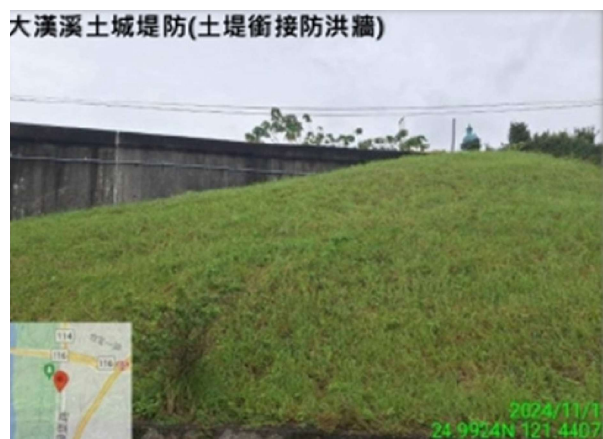
圖 1-32、大漢溪土城堤防（土堤接防洪牆）
