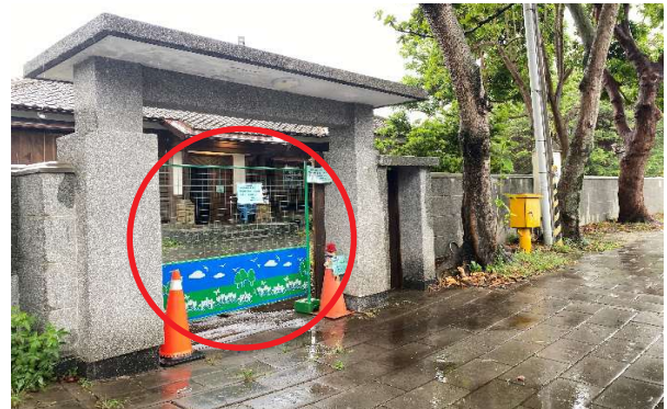
圖 1-19、檢察長宿舍緊急防護措施
